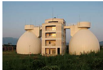
下水道センターの処理施設
